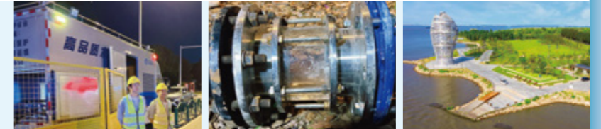
农村供水管网清洗 河南周口市
